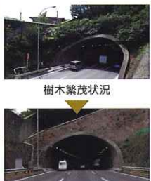
樹木繁茂状況 伐採後イメージ
