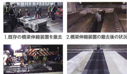
1.既存の橋梁伸縮装置を撤去 2.橋梁伸縮装置の撤去後の状況 3.新しい橋梁伸縮装置の設置 4.工事完了
