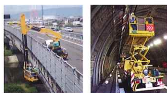
橋梁の点検 トンネル照明の点検
