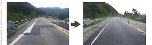
施工前 施工後
