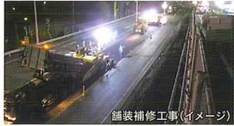
舗装補修工事(イメージ)
