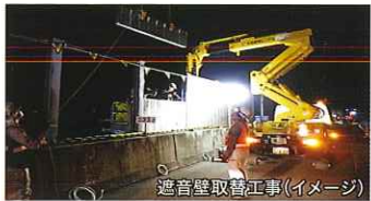
遮音壁取替工事(イメージ)
