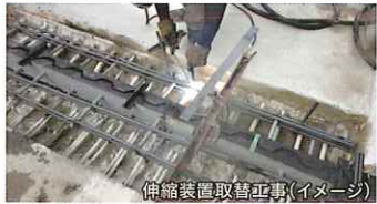
伸縮装置取替工事(イメージ)
