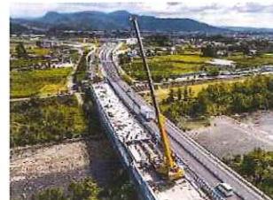
対面通行規制状況
