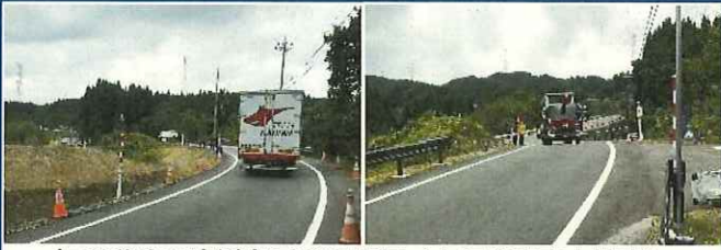
仮設道路の片側交互通行状況（小矢部市内山地区内）
