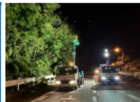
（維持修繕工事）
