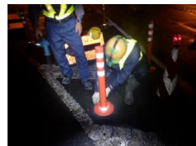
（道路附属物工事）
